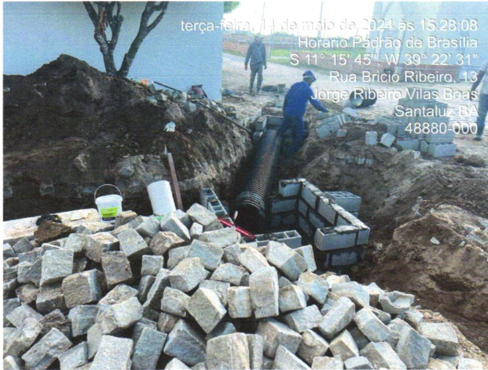
Foto 13 - FORNECIMENTO E ASSENTAMENTO DE TUBO CORRUGADO PAREDE DUPLA PEAD, D = 450 MM (18"), PARA SISTEMAS DRENAGEM, TIGRE - ADS N-12
