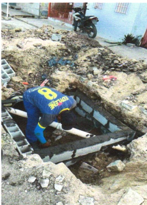
Foto 09 - ALVENARIA DE VEDAÇÃO DE BLOCOS VAZADOS DE CONCRETO DE 9X19X39CM (ESPESSURA 9CM) DE PAREDES COM ÁREA LÍQUIDA MAIOR OU IGUAL A 6M 2 COM VÃOS E ARGAMASSA DE ASSENTAMENTO COM PREPARO MANUAL. AF_06/2014
