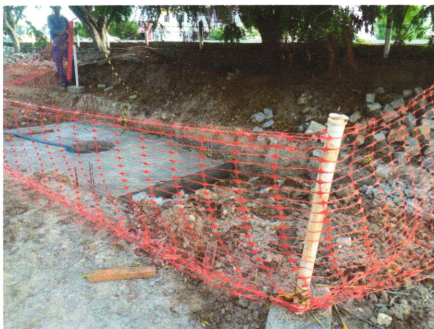
Foto 02 - Tapume de proteção em tela de polietileno h=1,20 com bloco de concreto
