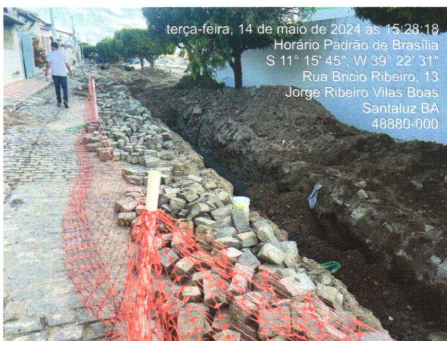
Foto 01 - Tapume de proteção em tela de polietileno h=1,20 com bloco de concreto
