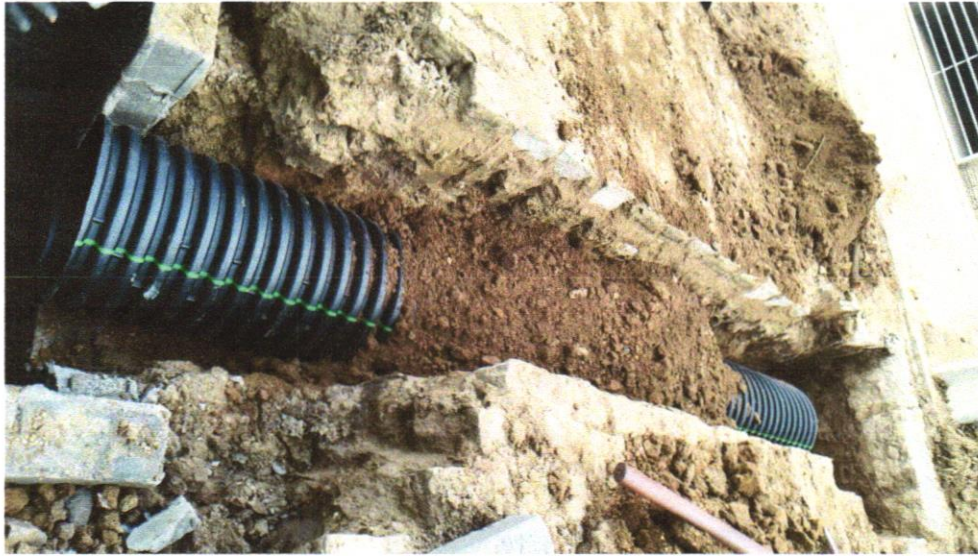
Foto 15 - FORNECIMENTO E ASSENTAMENTO DE TUBO CORRUGADO PAREDE DUPLA PEAD, D = 600 MM (24"), PARA SISTEMAS DRENAGEM, TIGRE - ADS N-12
