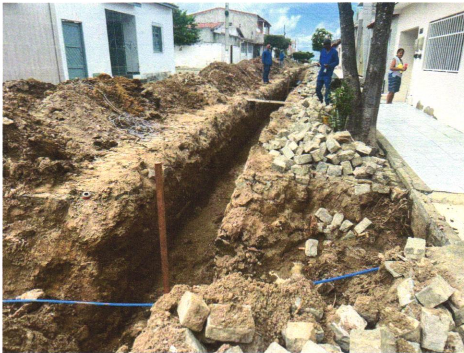
Foto 05 - ESCAVAÇÃO MECANIZADA ATÉ 1,50M EM MATERIAL DE 1º CATEGORIA PARA ABERTURA DE CORTE PARA ATERRO, SEM BOTA FORA
